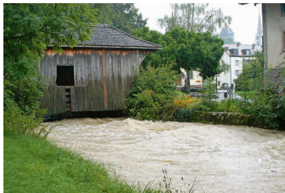
Nur noch wenig Platz blieb im Sommer 2013 zwischen den Aabachfluten und der Holzbrücke in der Unteren Farb in Uster. Pascal Sieber, Awel
